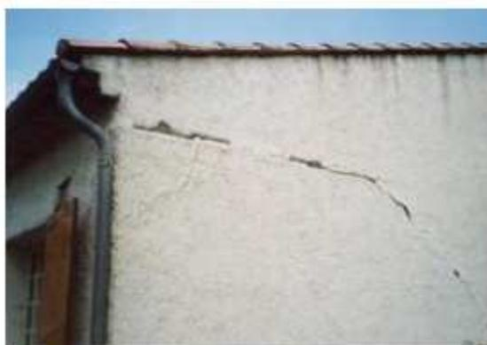
*Exemple de fissure causée par le phénomène de retrait-gonflement des argiles (source : BRGM).*
